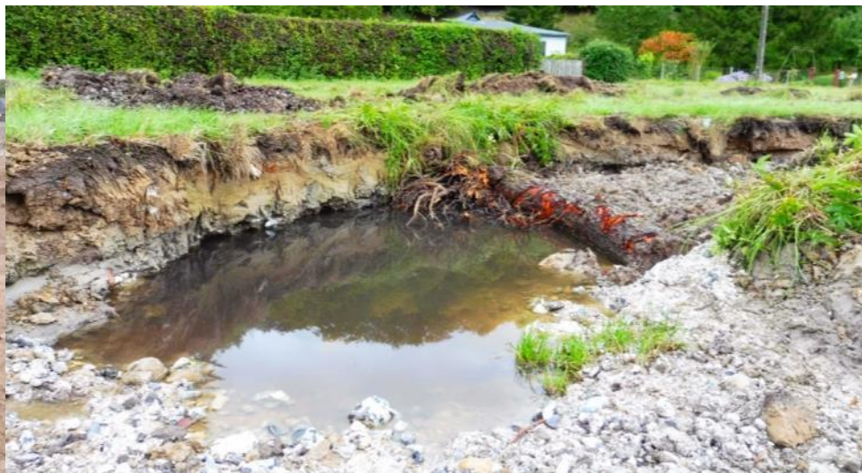
Creusement des mouilles et sous-cavement des berges (1,2m)
