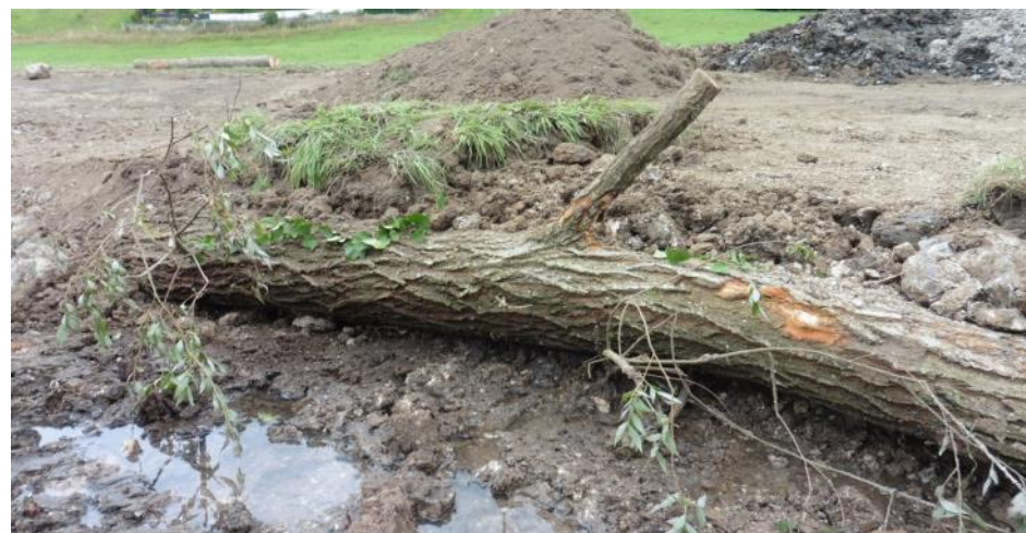
Mise en place de bois morts à de nombreux endroits : une trentaine d'arbres utilisée
