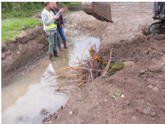
Mise en place de bois morts à de nombreux endroits : une trentaine d'arbres utilisée
