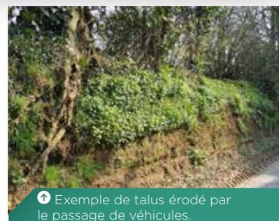
↑ Exemple de talus érodé par le passage de véhicules.
