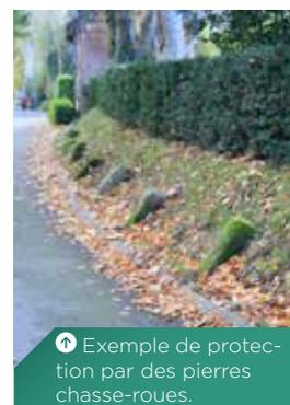
↑ Exemple de protection par des pierres chasse-roues.
